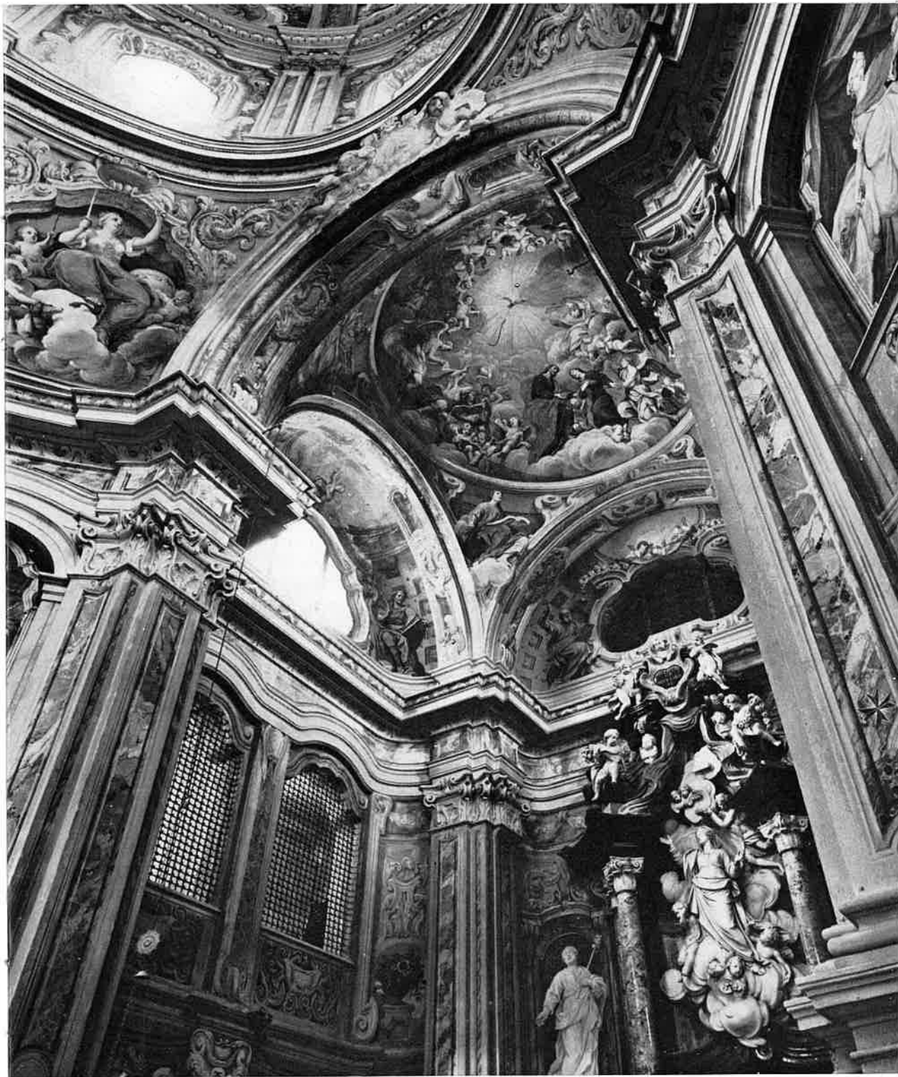
Particolare dell'abside dopo i restauri
