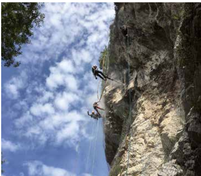
Il posizionamento delle reti metalliche alla Valletta
