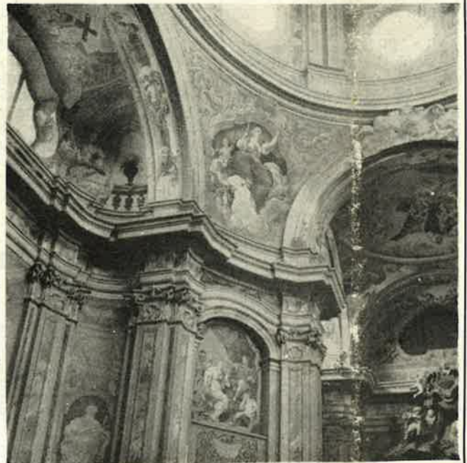
Interno della chiesa di S. Caterina prima dei restauri: un particolare degli affreschi del veronese Benaschi, sbiadito dal tempo e oggi riportato al primitivo splendore.
