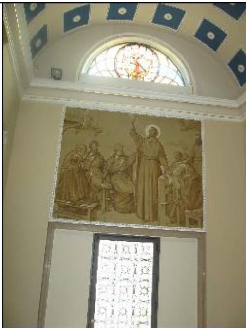
Foto 79: interno - dettaglio del prospetto Est del presbiterio
