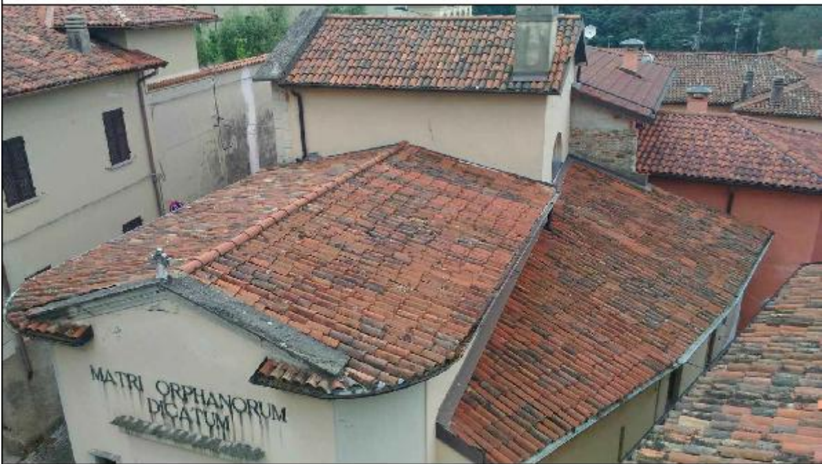
Foto 2: vista panoramica da Nord
