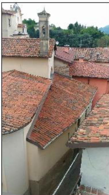
Foto 62: vista panoramica delle coperture
