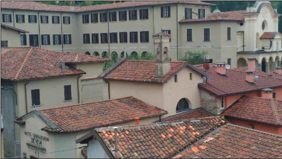
Foto 1: vista panoramica da Nord Ovest
