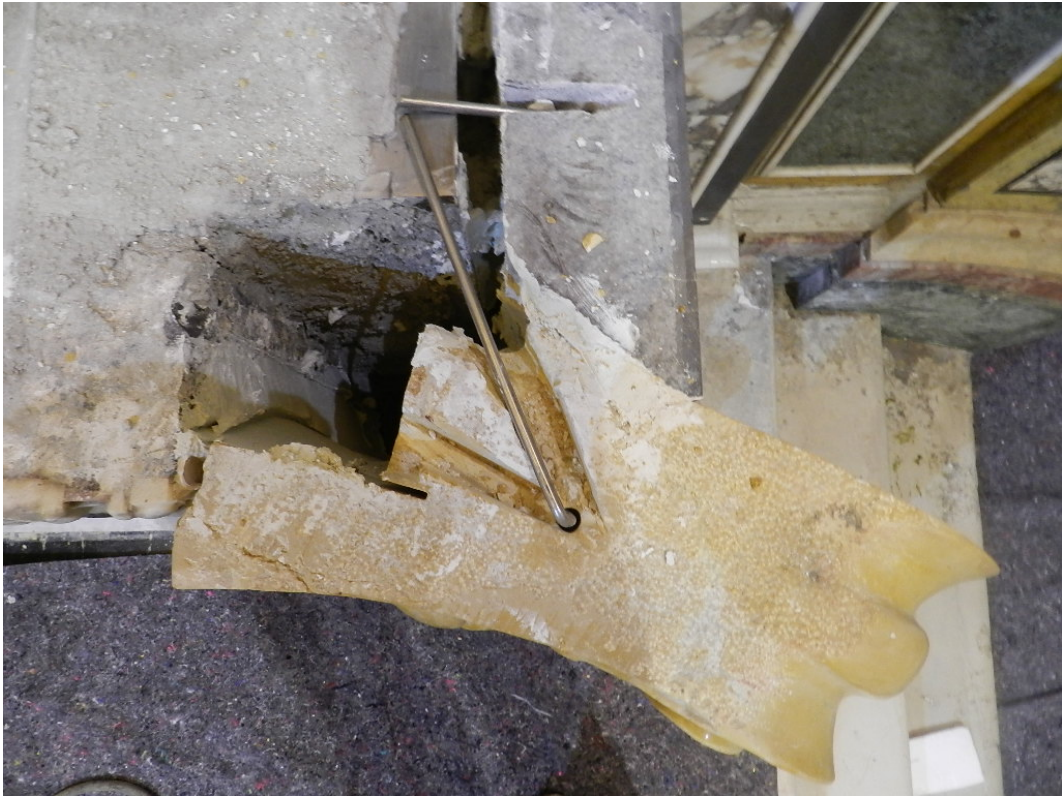
Ancoraggio con barre in acciaio
