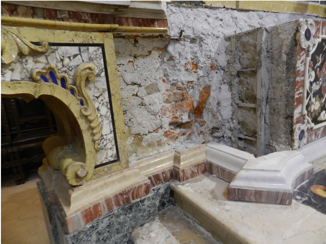
Riposizionamento blocchi di marmo della base
