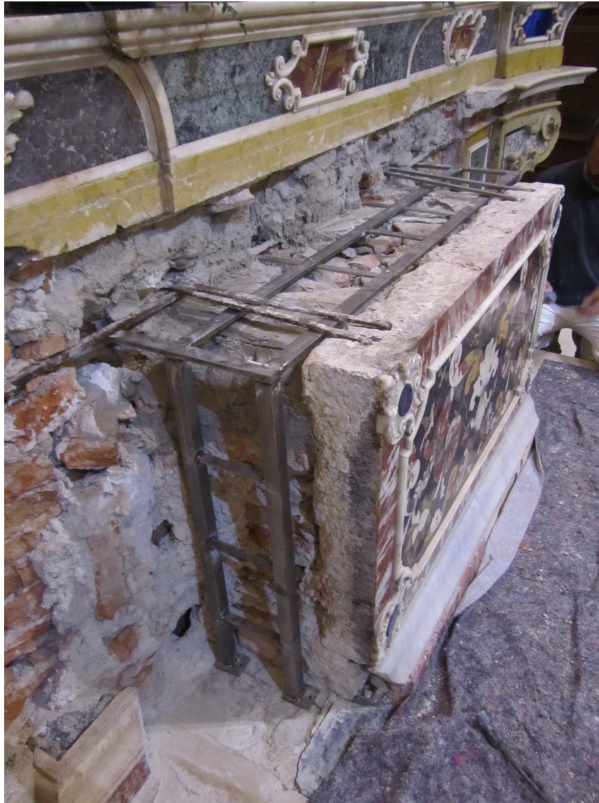
Struttura in acciaio per rinforzo strutturale
