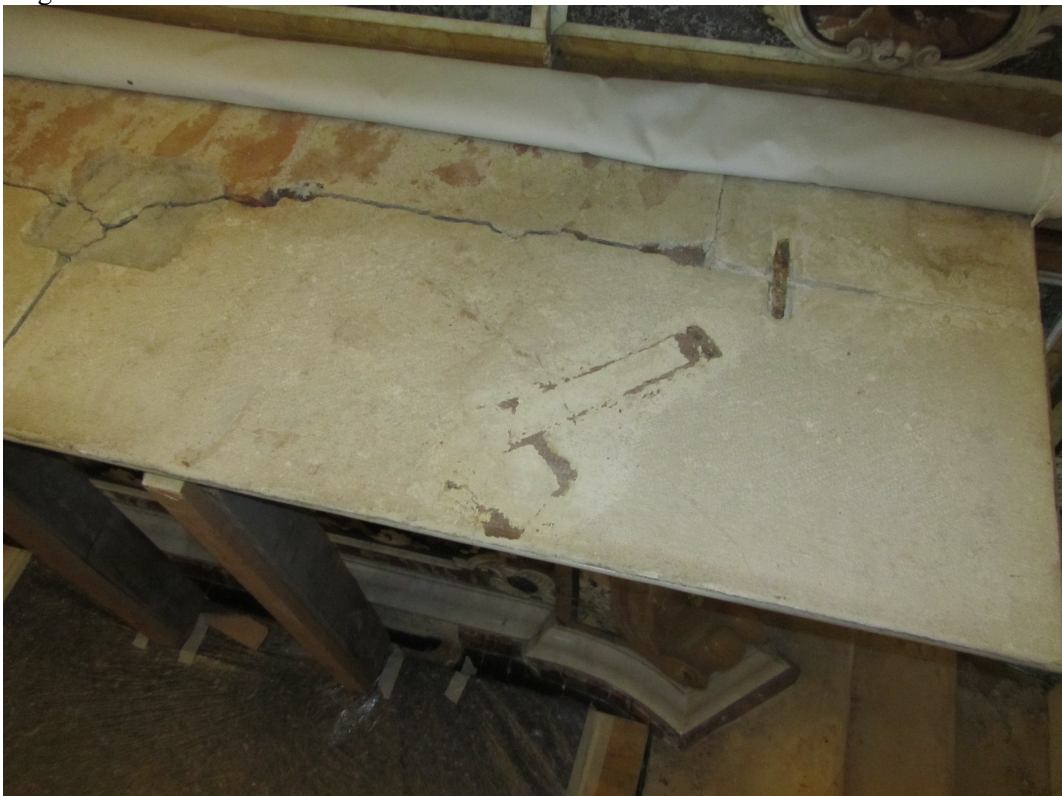
Piano mensa dopo la rimozione della pietra e dei residui di intonaco
