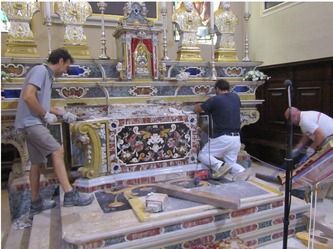
Fase di smontaggio di porzioni di mensa
