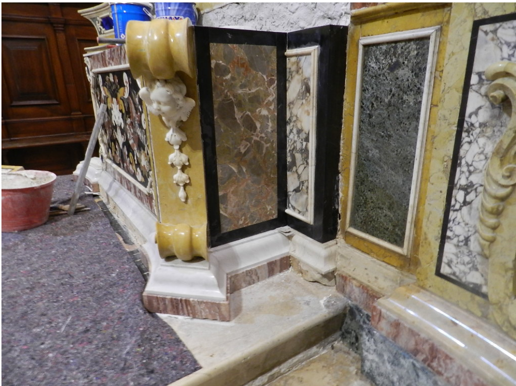
Riposizionamento blocchi di marmo lato destro
