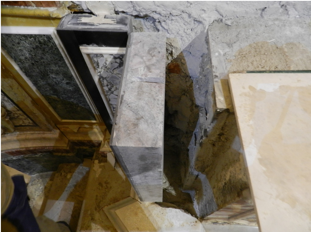
Riposizionamento pannelli laterali con supporti in granito
