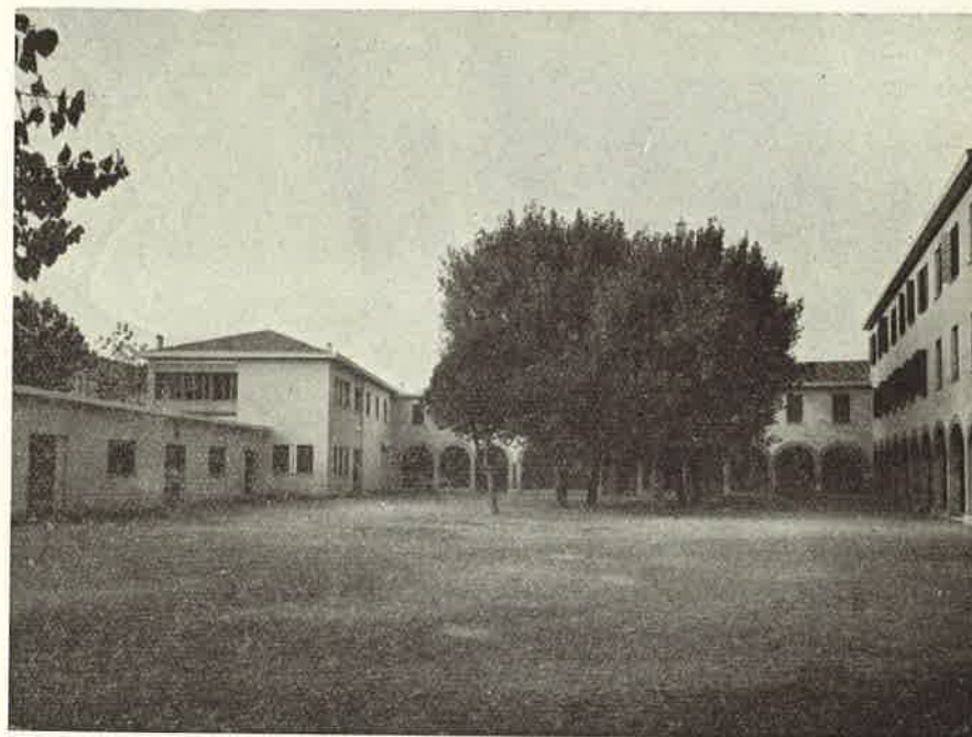
L'intera armoniosa costruzione vista dal lato interno. A sinistra, le officine.
