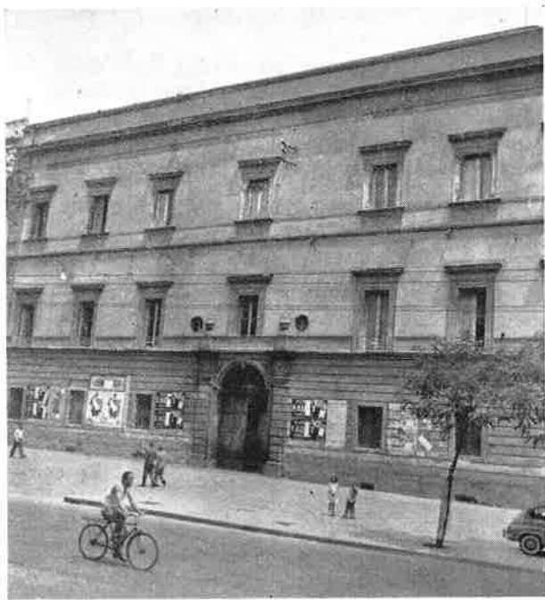
NAPOLI - Collegio Caracciolo dei PP. Somaschi; ora scuola elementare Bovio in piazza Carbonara (esterno)
