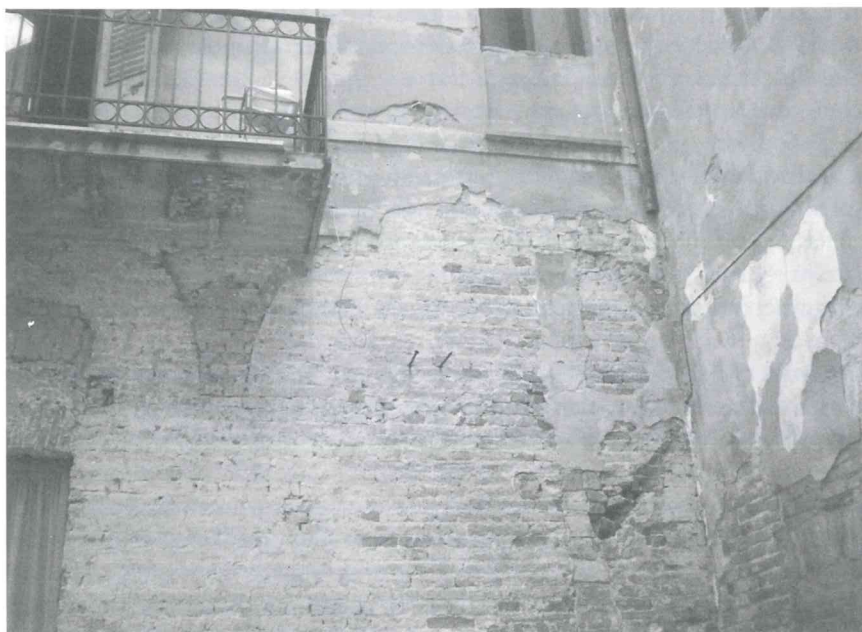
Figg. 11, 12 - Tracce della loggia demolita (peducci delle volte) e delle aperture tamponate sulla controfacciata prospiciente il cortile con ingresso da via R. Manna (anno 2001).
