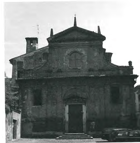
Fig. 19. La facciata nella situazione attuale.
