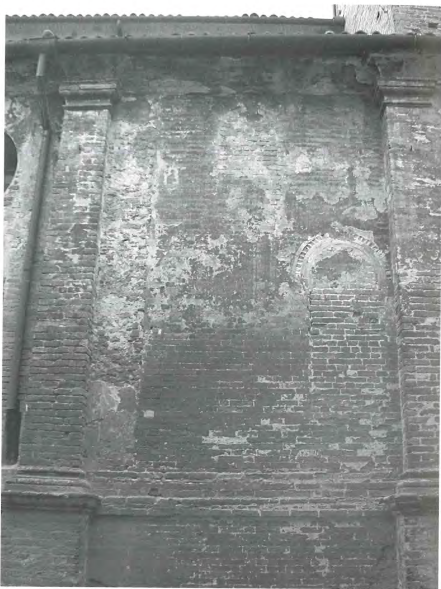
Fig. 11. Facciata laterale di Santa Lucia, sesta campata: a destra della lesena dorica si nota il contrafforte scalpellato della chiesa medievale, periodo la quale appartengono la muratura in mattoni rettificati con giunti sottilissimi e la finestra (tamponata successivamente) con l'archivolto in cotto.
