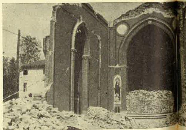
La Chiesina dell'Immacolata devastata dalle bombe (7 Aprile 1944).
