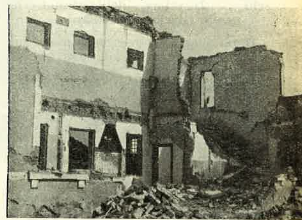
L'Orfanotrofio distrutto il 7 aprile 1944.
