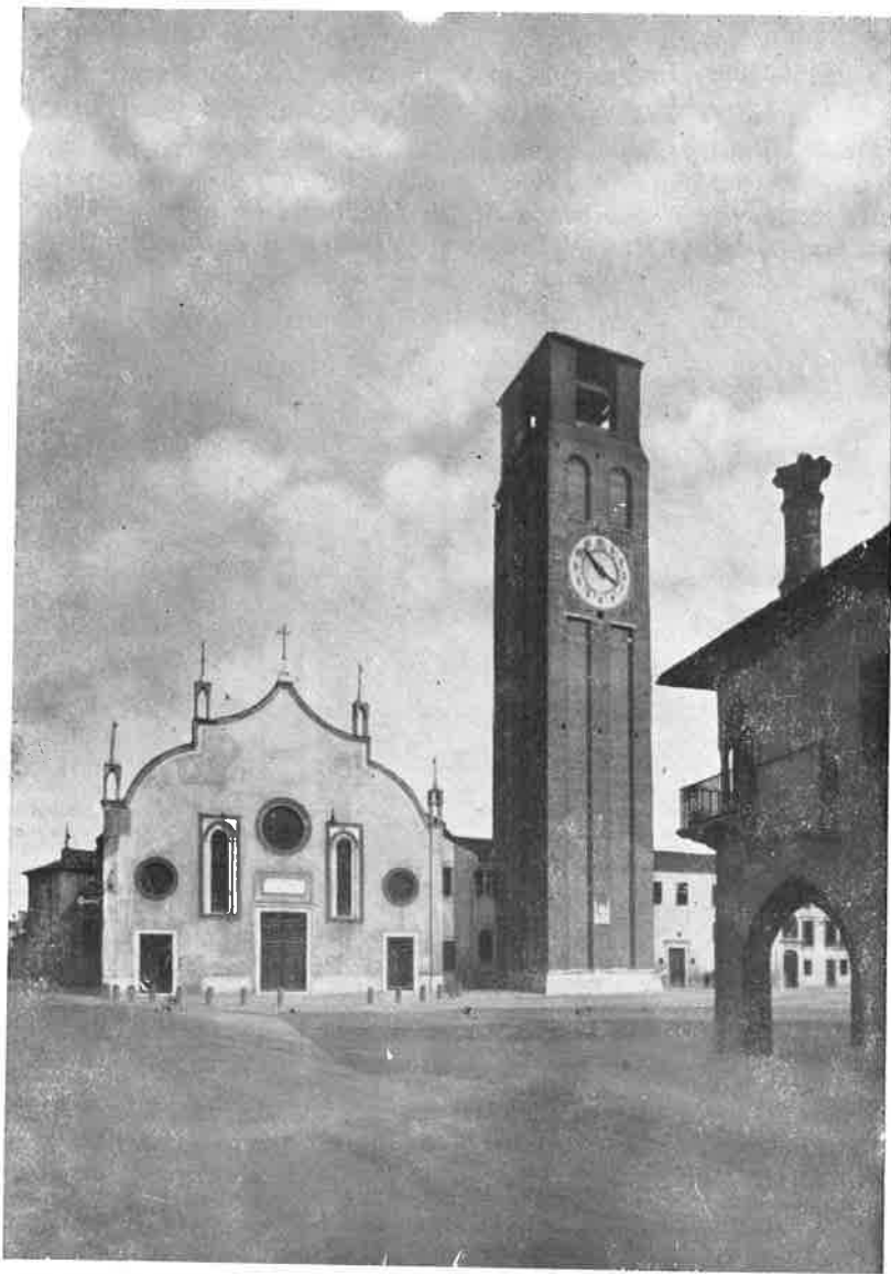
Guardare bene la facciata, che verso il 1940 era stata scrostata dalla Sovrintendenza ai Monumenti per desiderio di rimetterla alla sua origine.
